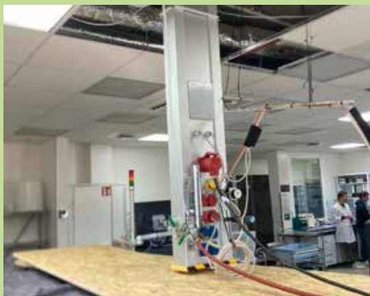
Umbau der Mediensäulen
