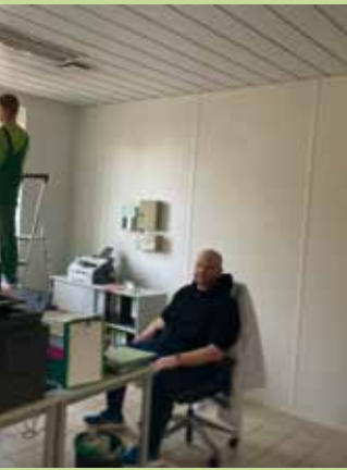
Fließender Umbau zur neuen Kühlzelle
